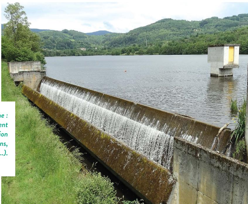
*Travaux au barrage d'Aubusson d'Auvergne : un projet exemplaire pour l'environnement et la sécurité (amélioration de la capacité d'évacuation du lac, construction d'une passe à poissons, production d'électricité verte...).*
