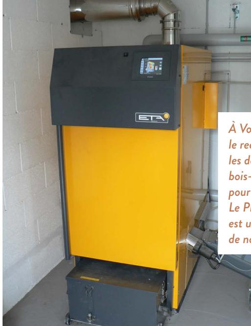
À Vollore-Montagne, afin de favoriser le recours au bois-énergie et réduire les dépenses énergétiques, une chaudière bois-plaquette a été installée pour la mairie et l'école. Le Plan-Climat-Air-Énergie Territorial est un outil qui permettra de développer de nouveaux projets.
